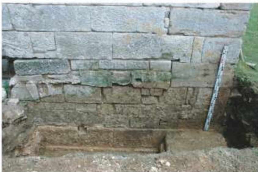
Parement de la tour-porte et ressauts de fondation
